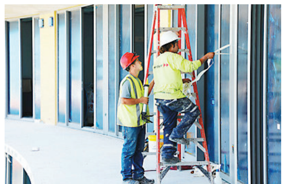
当地工人在新地标项目施工现场工作
