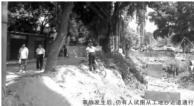
事故发生后,仍有人试图从工地抄近道通行
